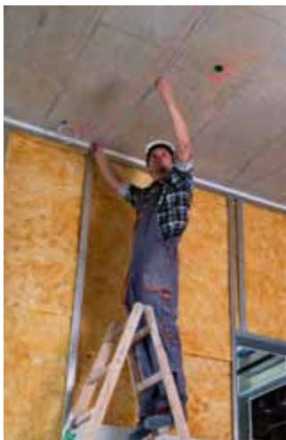
▲ Перенос плана с фундаментной плиты на стены и полочки.
