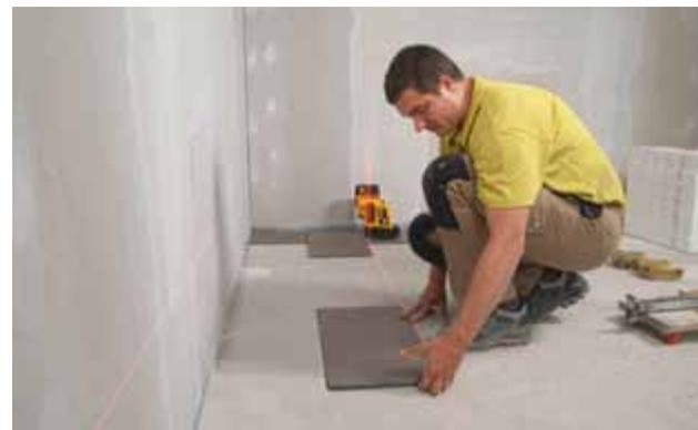
◀ За счет **функциональной формы** его корпуса лазерный прибор можно просто установить на стенах или в углах. Таким образом, без всяких проблем определяется поверхность для укладки плиток.
